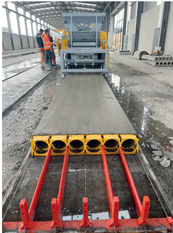
Экструдер EVO2 на стадии бетонирования
